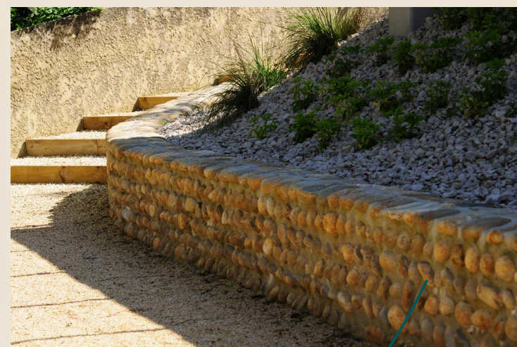
Muret en galets
